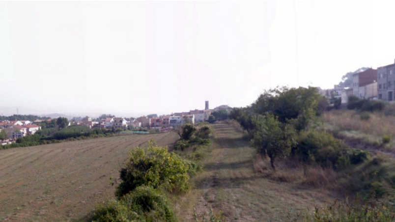
Figura 26. Vista de la SSEE municipal
