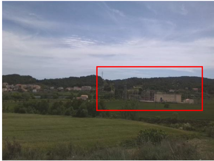
Figura 27. Vista de la SSEE municipal
