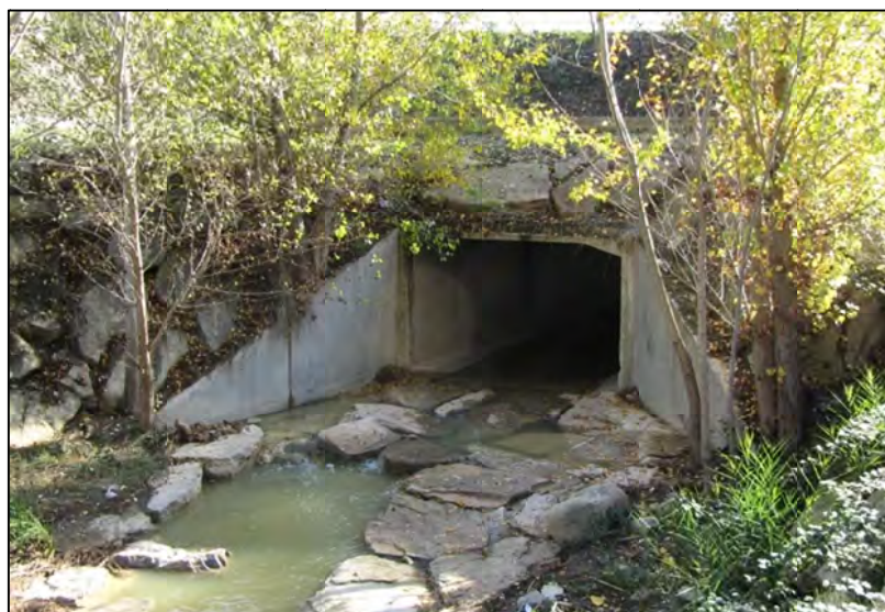
Figura 32. Estructura R9. Culvert sobre el torrent de Can Rafeques, a l'entrada del nucli urbà de Santa Margarida de Montbui per la carretera de Valls (C-37).
