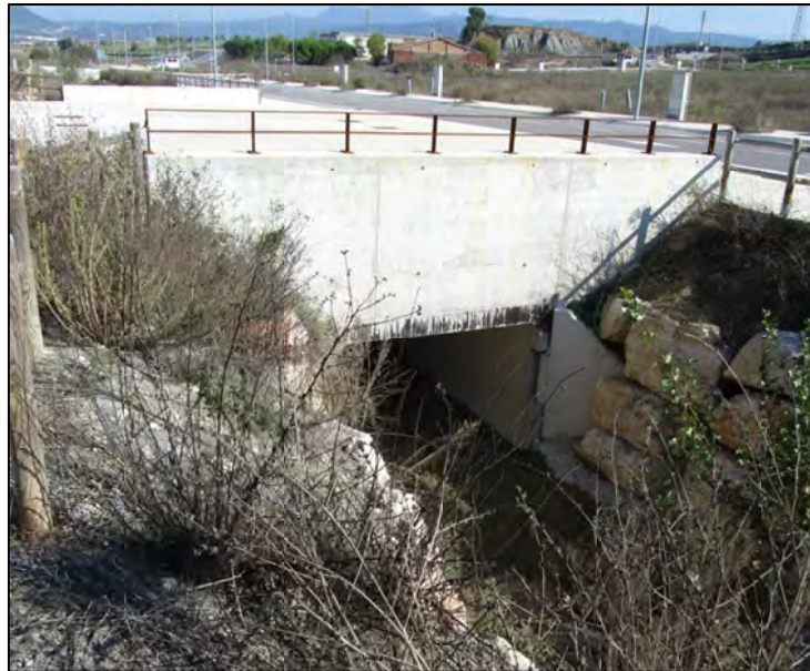
Figura 25. Estructura R2. Culvert sobre el torrent de Can Rafeques al polígon industrial dels Plans de la Tossa.
