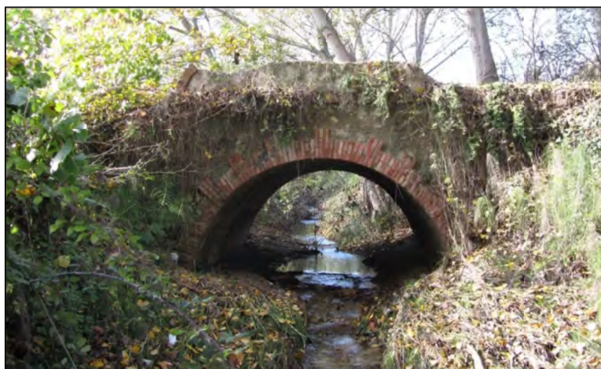
Figura 40. Estructura G5. Pont sobre el torrent de Garrigosa al camí de la Serra.
