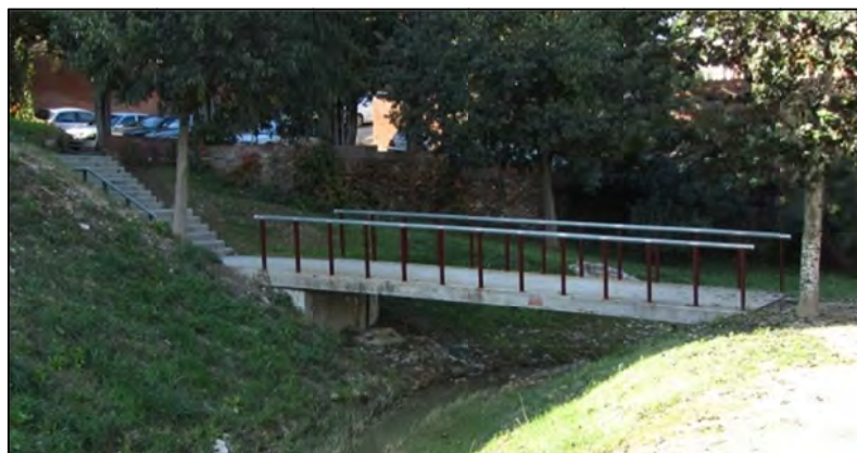
Figura 35. Estructura R12. Passarel·la de vianants sobre el torrent de Can Rafeques a l'alçada del carrer de Santa Anna.
