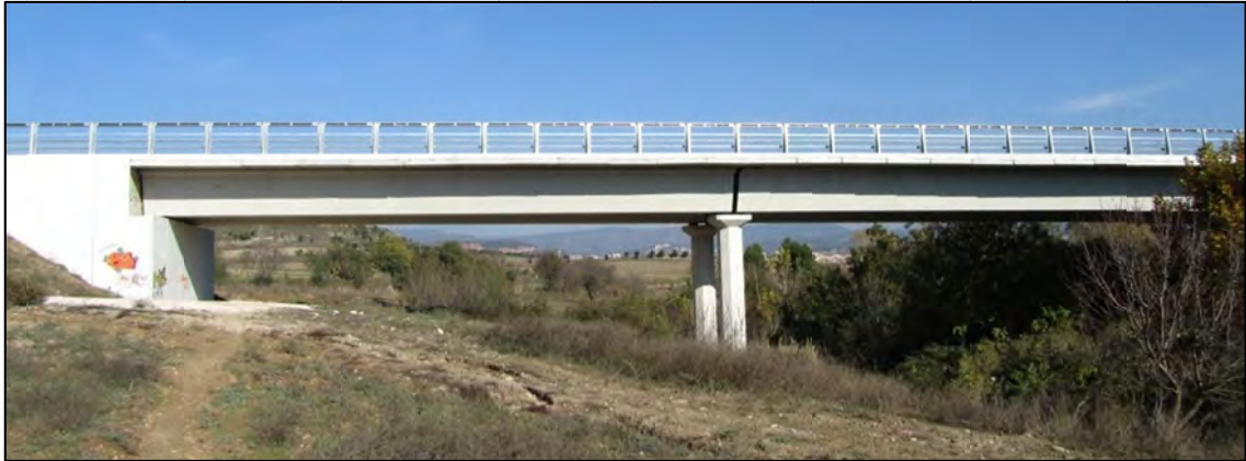
Figura 42. Estructura G8. Viaducte sobre el torrent de Garrigosa de la nova carretera C-37.
