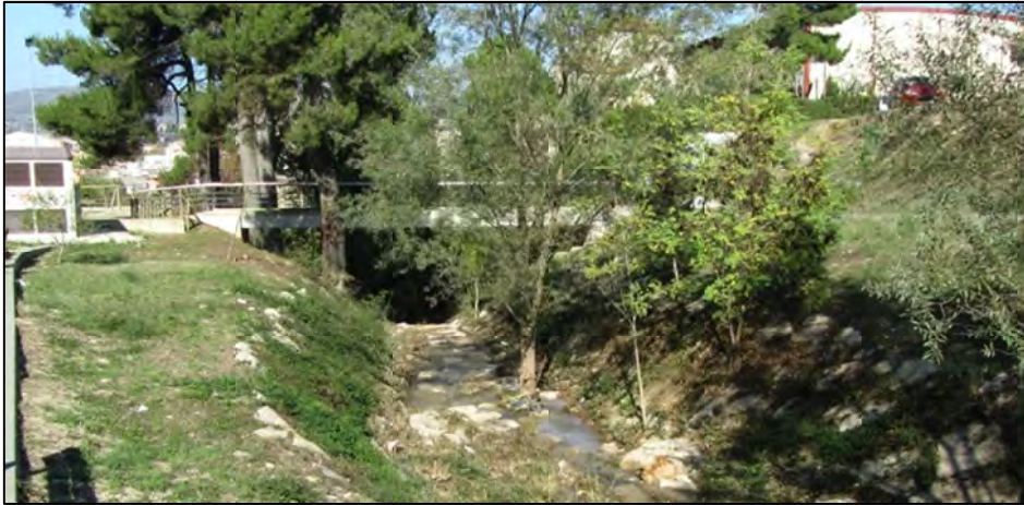
Figura 33. Estructura R10. Passarel·la de vianants sobre el torrent de Can Rafeques a l'alçada del carrer de la Font.
