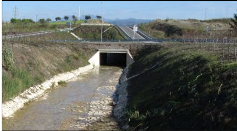
Figura 30. Estructura R7. Culvert sobre el torrent de Can Rafeques, a la girola de la carretera C-37 d'accés al polígon industrial dels Plans de la Tossa.
