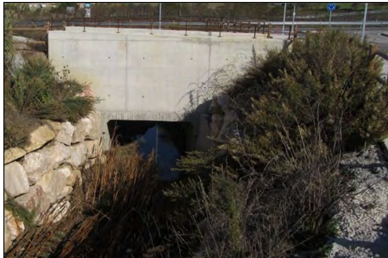
Figura 28. Estructura R5. Culvert sobre el torrent de Can Rafeques a la seva sortida del polígon industrial dels Plans de la Tossa.
