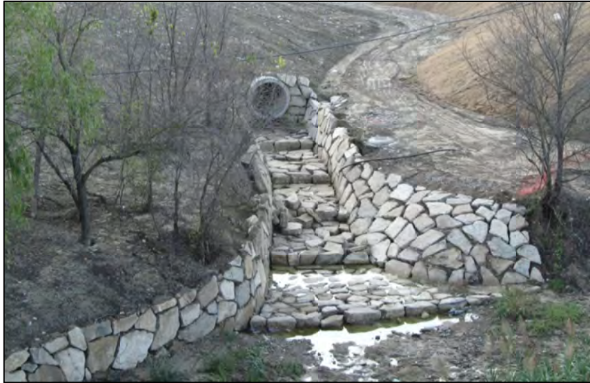
Figura 21. Estructura CL2. Sortida del soterrament del torrent de la Clota a confluència amb l'Anoia.
