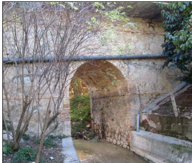
Figura 34. Estructura R11. Pont sobre el torrent de Can Rafeques al carrer del Pont.
