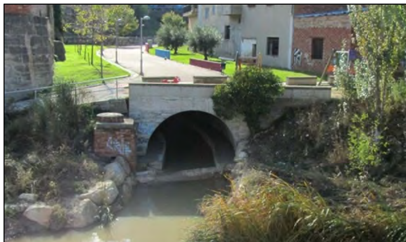
Figura 23. Estructura B2. Sortida del soterrament del torrent de les Bruixes a la confluència amb l'Anoia.
