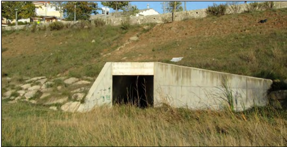
Figura 22. Estructura B1. Entrada del soterrament del torrent de les Bruixes al nucli urbà de Santa Margarida de Montbui.
