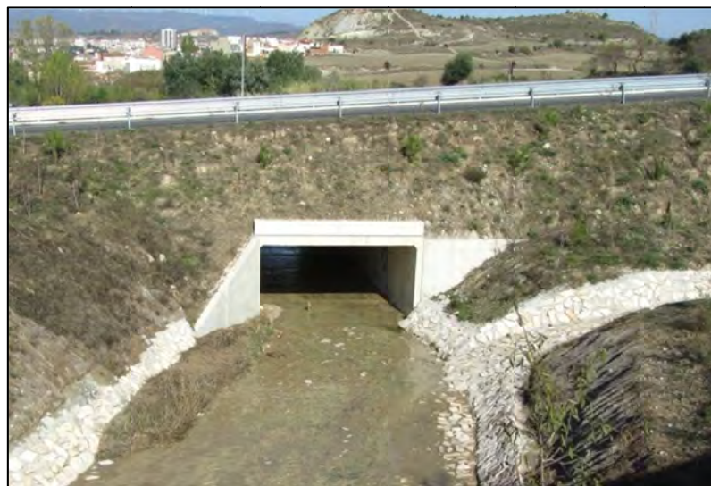
Figura 31. Estructura R8. Culvert sobre el torrent de Can Rafeques, a la carretera C-37.
