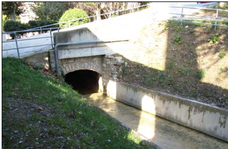
Figura 37. Estructura R14. Entrada del soterrament del torrent de Can Rafeques al carrer de la fàbrica.
