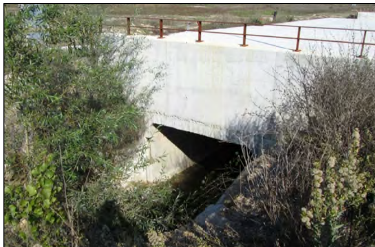
Figura 26. Estructura R3. Culvert sobre el torrent de Can Rafeques al polígon industrial dels Plans de la Tossa.
