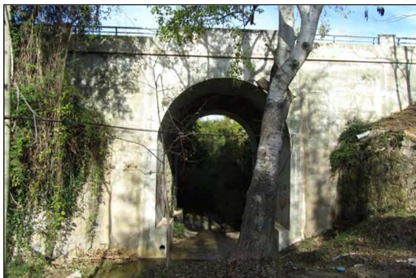
Figura 38. Estructura G2. Pont sobre el torrent de Garrigosa de la carretera C-37.
