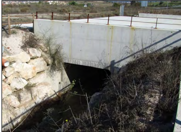
Figura 27. Estructura R4. Culvert sobre el torrent de Can Rafeques al polígon industrial dels Plans de la Tossa.
