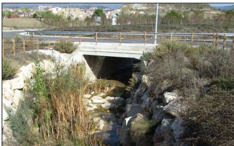
Figura 29. Estructura R6. Culvert sobre el torrent de Can Rafeques, a la girola de la carretera C-37 d'accés al polígon industrial dels Plans de la Tossa.
