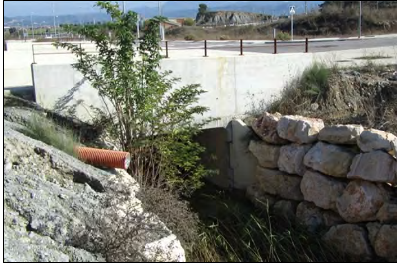
Figura 24. Estructura R1. Culvert sobre el torrent de Can Rafeques al polígon industrial dels Plans de la Tossa.
