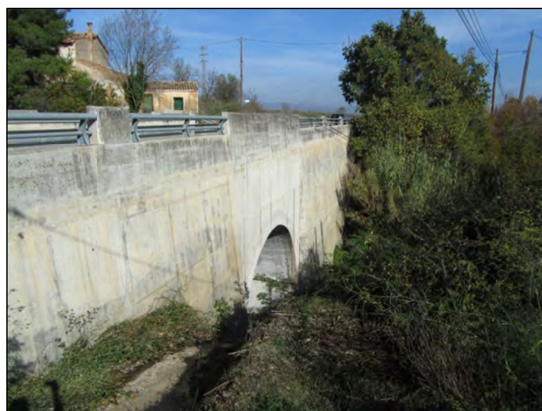
Figura 41. Estructura G6. Pont sobre el torrent de Garrigosa de la carretera C-37.
