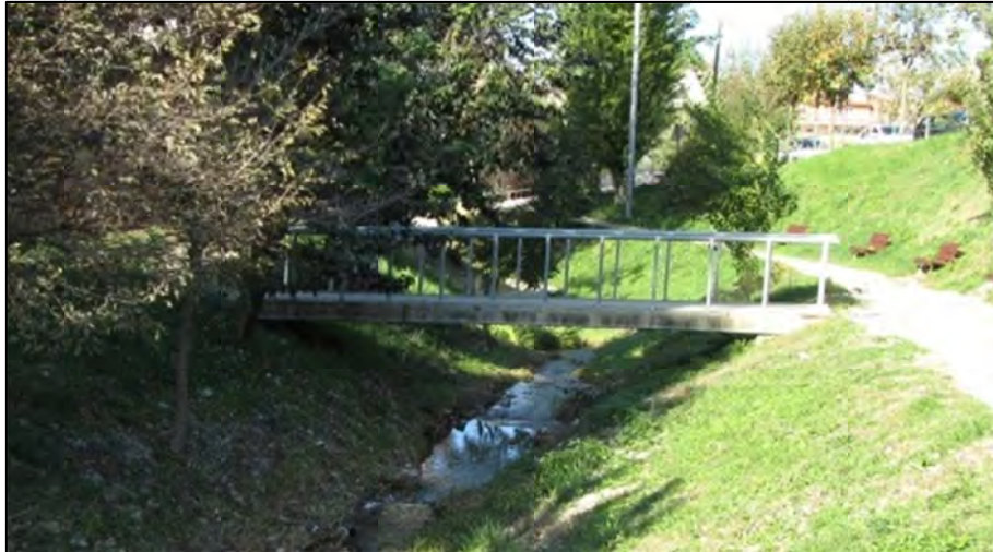
Figura 36. Estructura R13 Passarel·la de vianants sobre el torrent de Can Rafeques a l'alçada del centre cívic.
