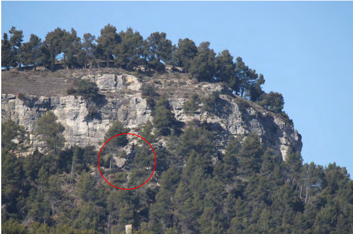
Fotografia 18: Ressalt rocós de la tossa de Montbui amb un despreniment reconeixible al peu de la cinglera (cercle vermell).
