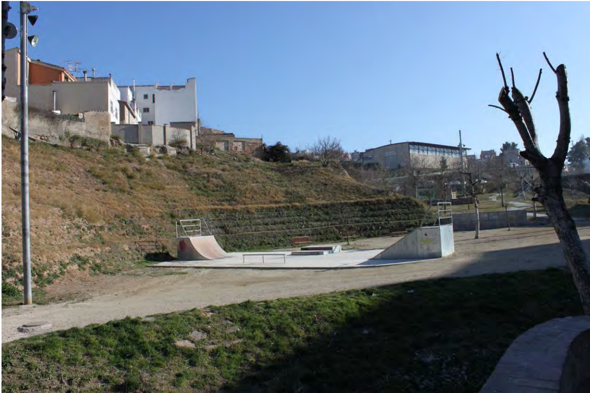
Fotografia 5: marge esquerre del torrent de can Rafeques Amb una actuació de correcció dels talussos de margues amb un mur vegetal adossat.
