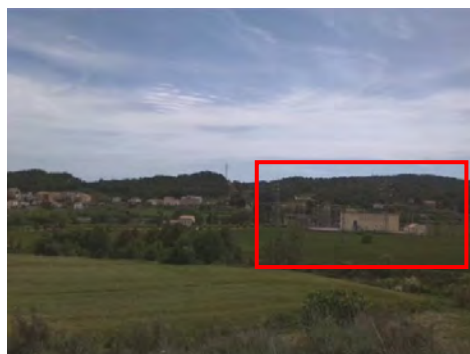
Figura 26. Vista de la SSEE municipal
